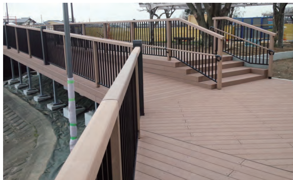
埼玉県越谷市葛西用水張出デッキ
