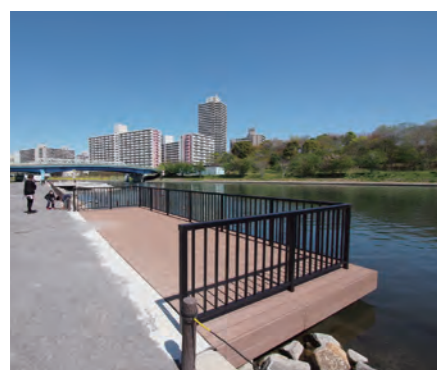
江東区川の駅張出デッキ
